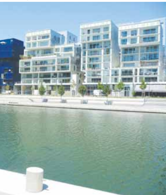
Le nouveau quartier de la ZAC Lyon Confluence, 2011
