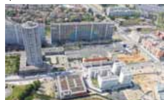
Les grands-ensembles du quartier de la Duchère à Lyon, début 2010
