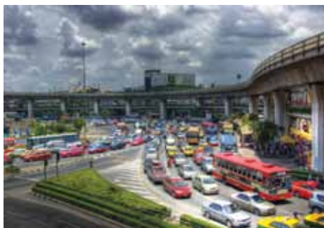
◀ À Bangkok, la construction de voies rapides surélevées n'a pas réussi à réduire significativement les embouteillages
