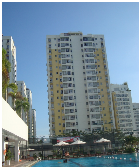
Figure 16: Piscine à PMH
