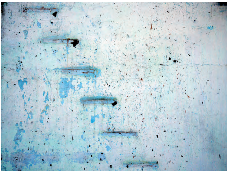
Traces d'escaliers sur le mur latéral d'une maison détruite.
