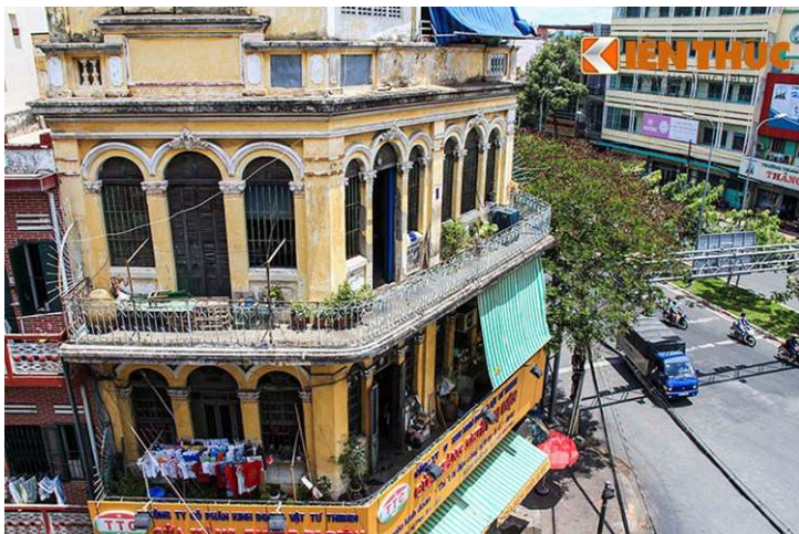
Thời gian tồn tại quá lâu cùng việc không chú trọng gìn giữ khiến khu phố cổ Sài Gòn không những bị thay đổi khác xưa mà còn xuống cấp trầm trọng.
